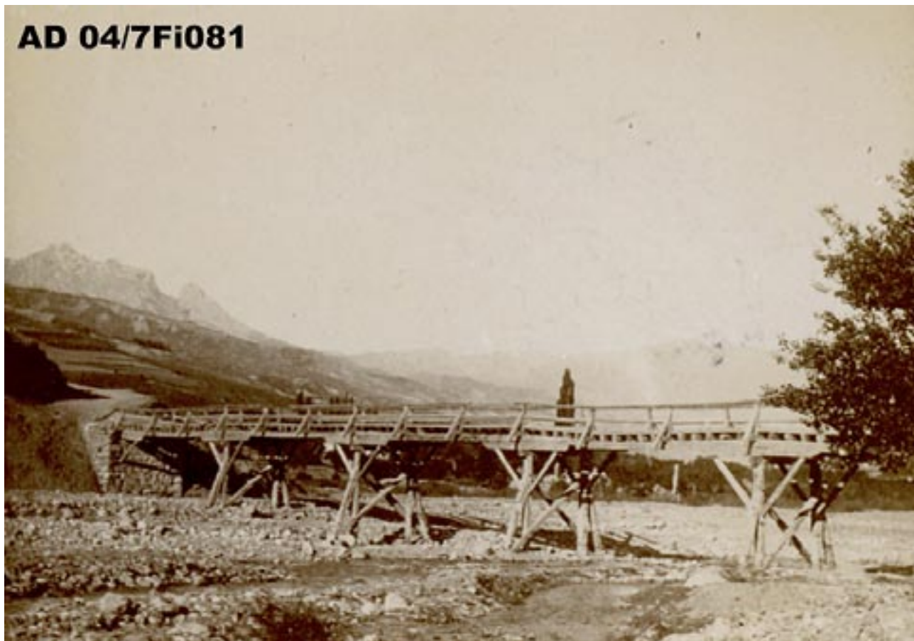
Prise de la rive gauche, vue d'ensemble du Pont Long.
