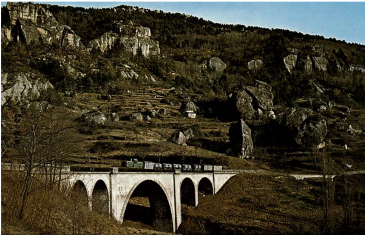
CHEMIN DE FER DE PROVENCE - Train de marchandises sur le viaduc de la Beïte à Annot.
