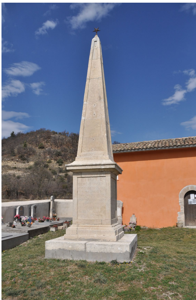
Fig. 10. Obélisque, cimetière de la chapelle de Beauzezer, Mirabeau
