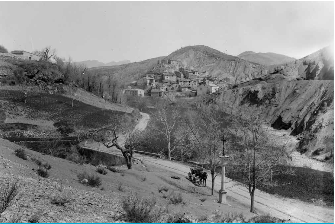
Vaumeilh, vue générale, 1890. Arch. dép. AHP, 31 Fi 0021
