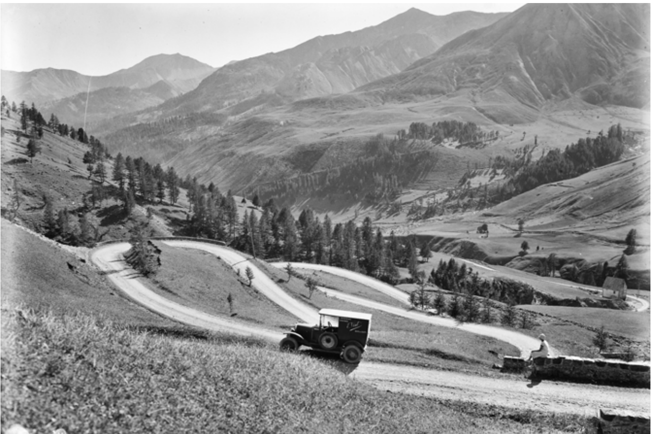
Col d'Allos, 1923. Arch. dép. AHP, 207 Fi 2588
