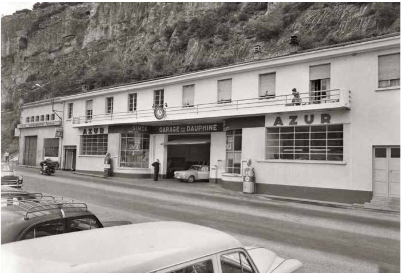
Garage Azur, porte du Dauphiné, Sisteron, 1960. Arch. dép. AHP, 51 Fi 2343
