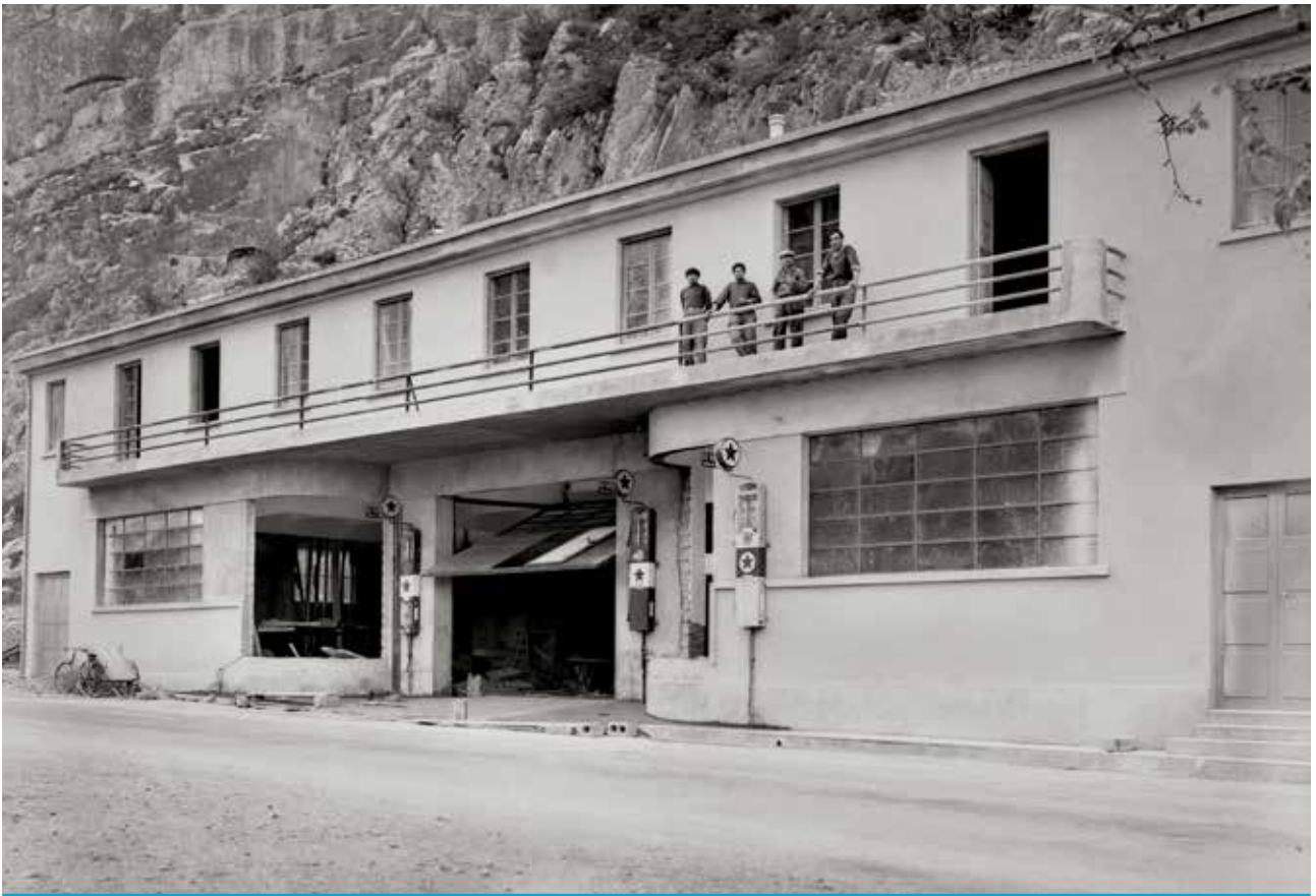
Garage Brun, porte du Dauphiné, Sisteron, 1930. Arch. dép. AHP, 51 Fi 2052
